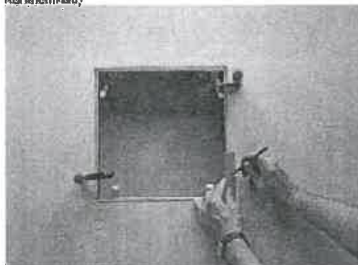
3. Rahmen ausrichten (Winkelmess prüfen), festspannen und Bohrungen mit Schablone anzeichnen, Bohrabstand <math>< 250 \text{ mm}</math>
