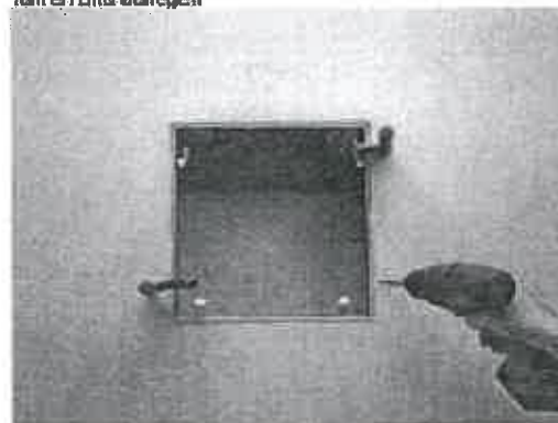
4. Rahmen verschrauben und beiliegende Schutzkappen aufstecken
