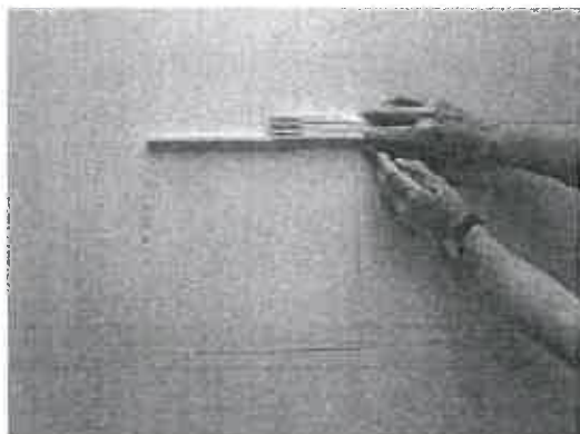
1. Bauöffnungsmaß anzeichnen und aussägen (+6 mm größer Rahmenmaß)
